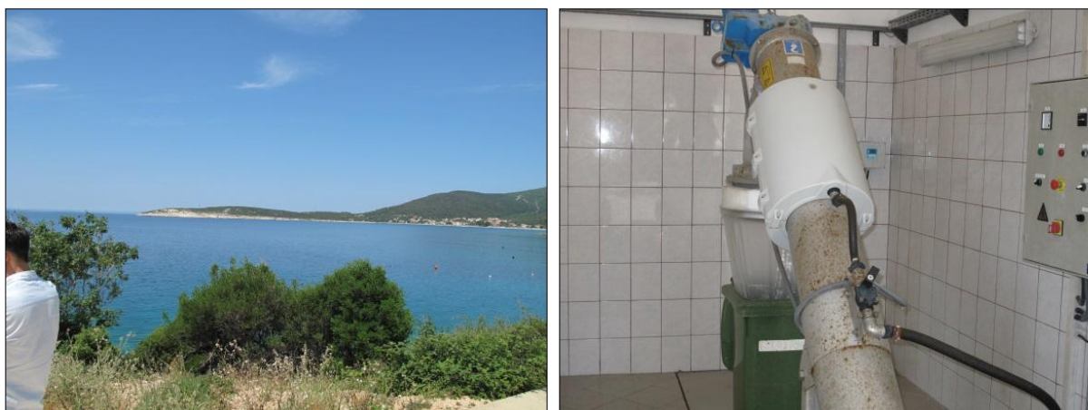
Slika 2.1.2-2. Postojeći uređaj za pročišćavanje otpadnih voda Martinšćica (mehanički predtretman) s podmorskim ispustom
